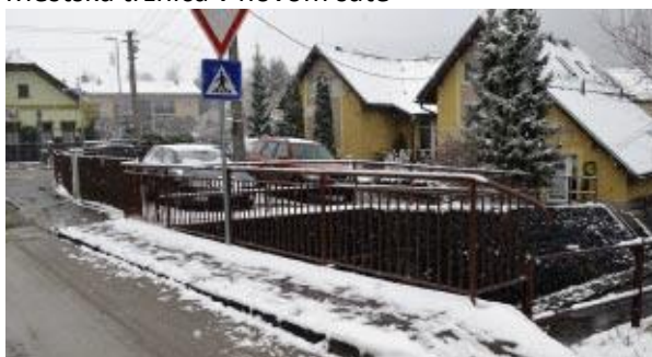
Opravené zábradlie na moste cez Bystričku
