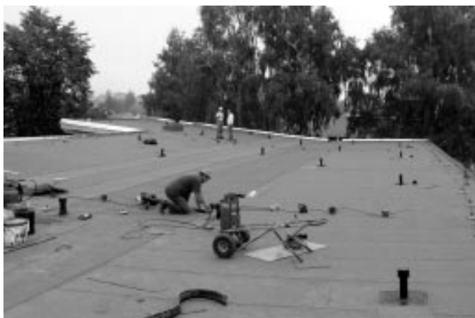
Práce na rekonštrukcii strechy školy
