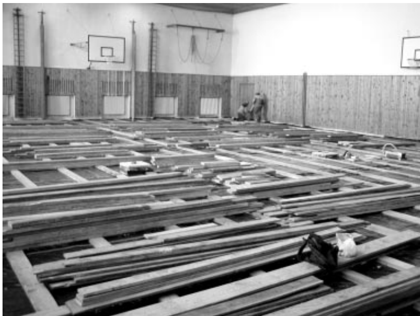
Budovanie novej palubovky v telocvični
